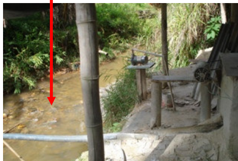
Figura 29 – Disposição inadequada de rejeitos
