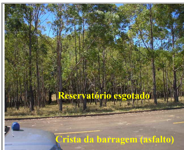
Figura 4.2 – Vista da barragem 4, CBMM, em fase final de fechamento (plantação de eucalipto).
