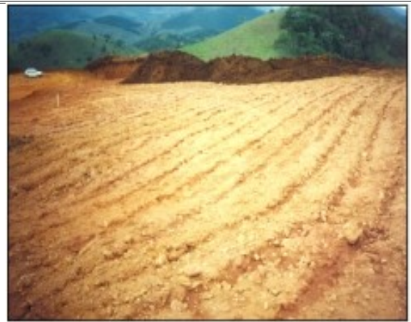
Figura 4.13 – Reconformação topográfica da cava com preenchimento do material retirado de outra faixa a ser lavrada.
