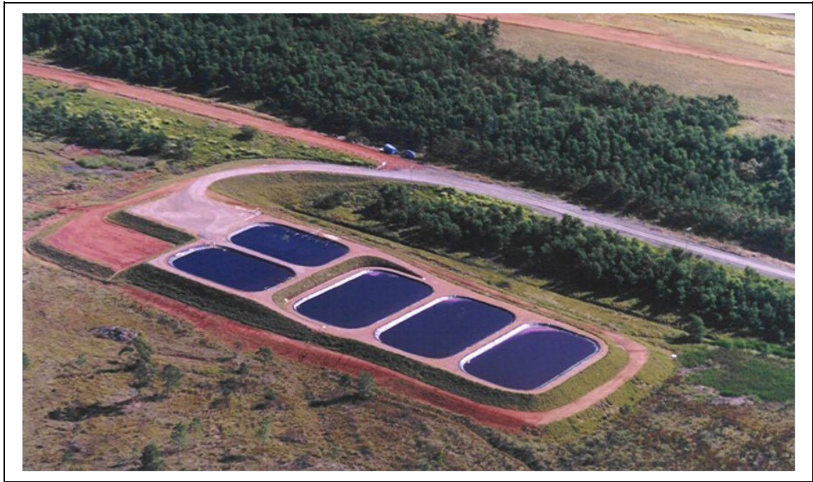
FIGURAS 6.34 - Vista da Estação de Tratamento de Efluente - ETE (Chorume)
