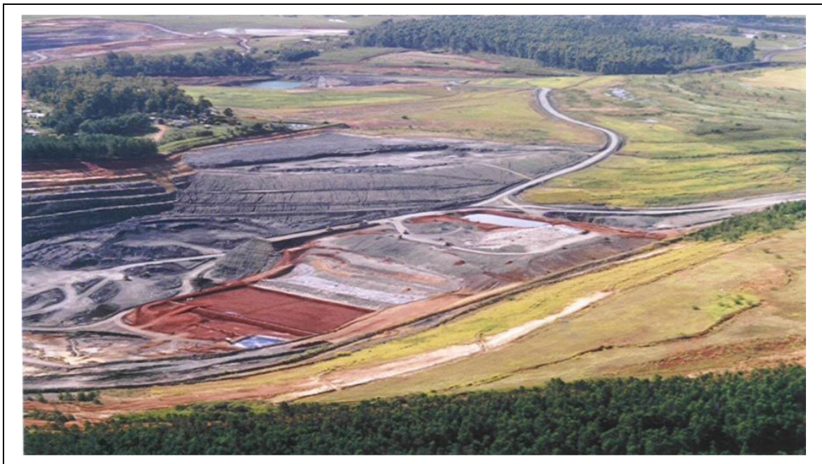
FIGURAS 6.35 - Aterro em operação (junho de 2004)
