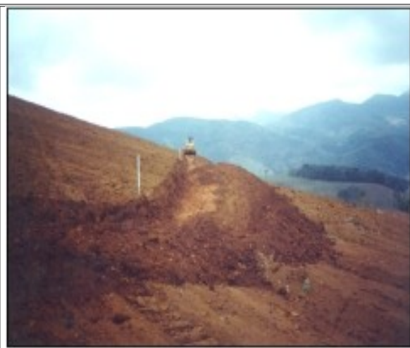
Figura 4.14 – Abertura de curvas de nível.
