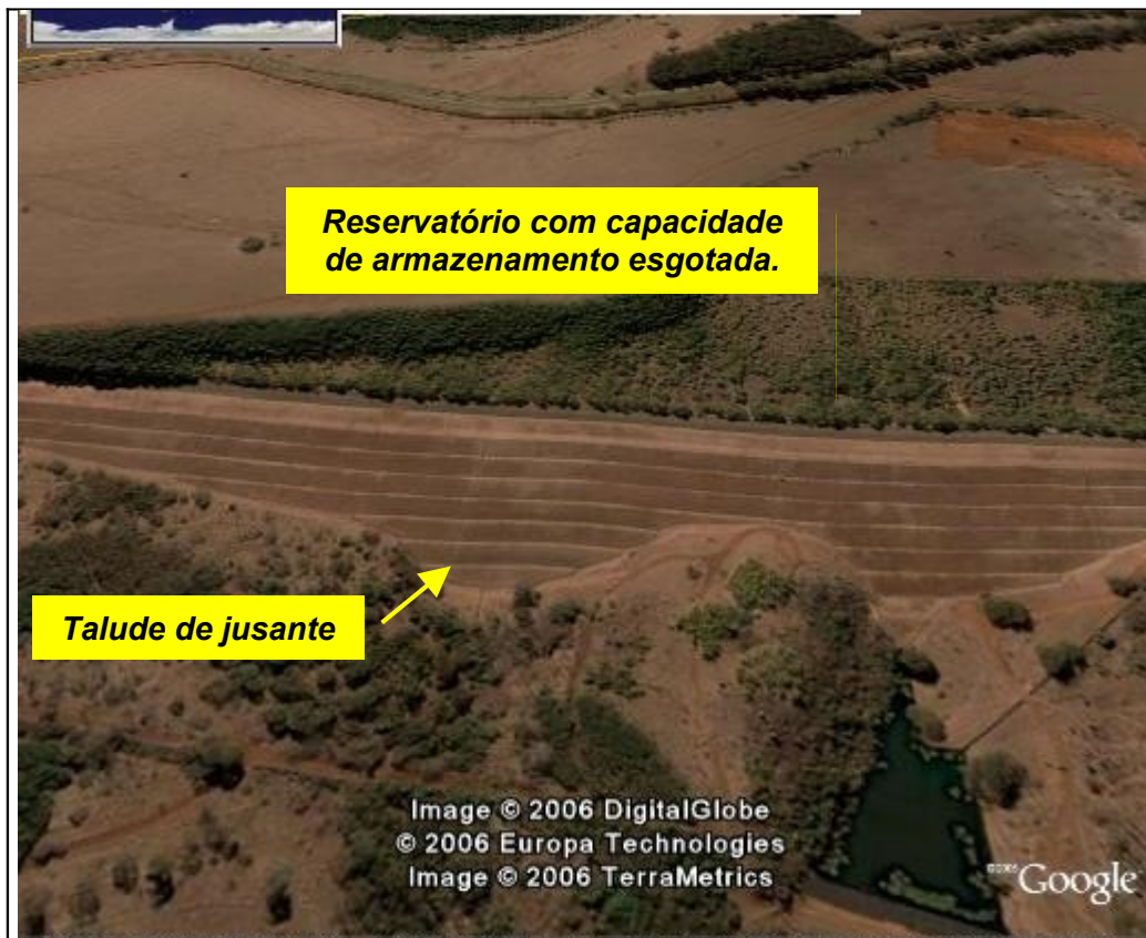
Fig. 4.1 – Imagem da barragem 4 (CBMM, Araxá) em fase de desativação.
