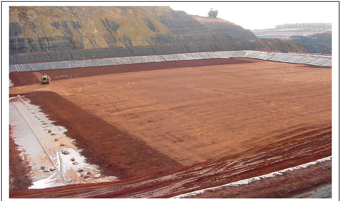
FIGURAS 6.31 - Cobertura protetora da geomembrana (com argila)
