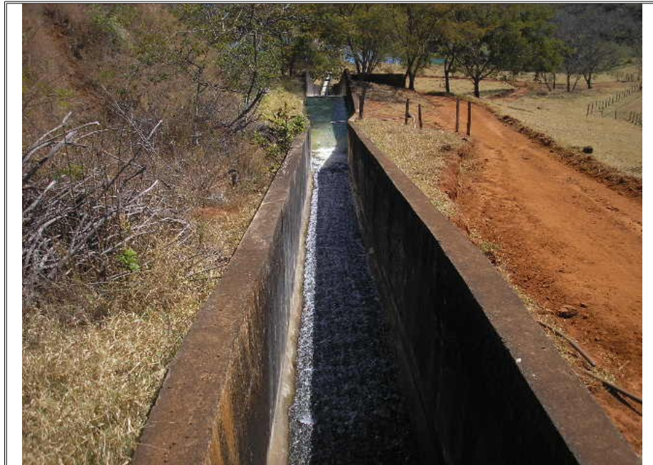
Figura 4.4 – Vertedouro de sangramento, onde são tratadas as águas que bombeadas na barragem 4 e as águas pluviais que circundam a barragem.
