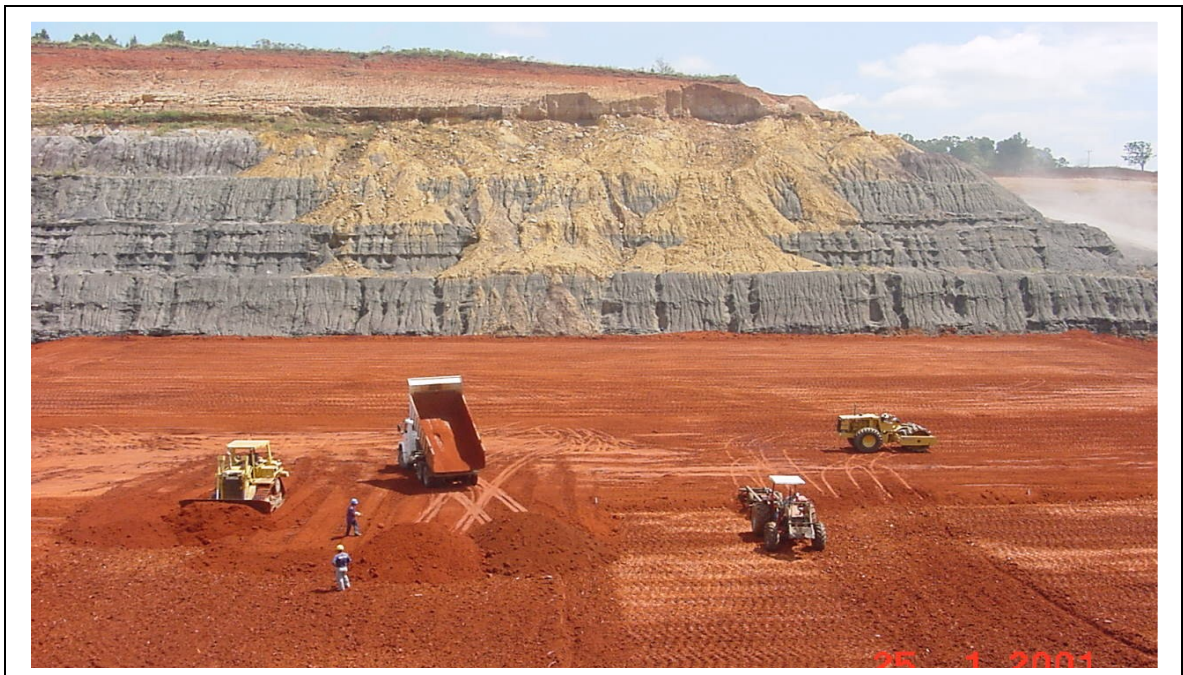
FIGURAS 6.29 – Impermeabilização do fundo da cava, com camada de argila
