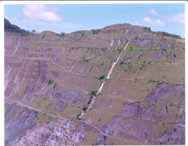
Figura 6.3 –Detalhe do talude da cava da Mina de Águas Claras. O talude que está sendo modificado visando adequar o coeficiente de segurança para o fechamento.
