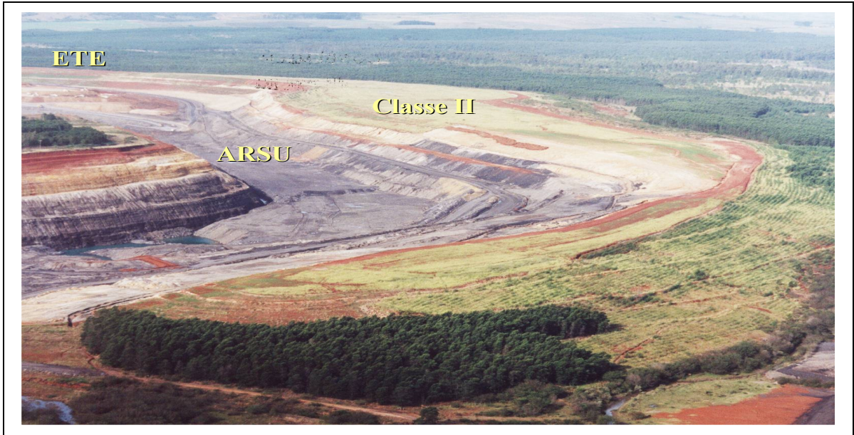
FIGURAS 6.28 – Vista Geral da área do ARSU
