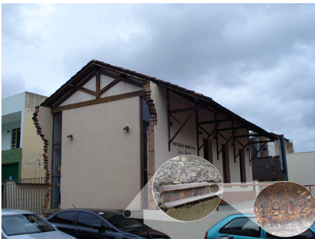
Figura 2.10- Estação Memória Zeza Souto 7 / Vista lateral esquerda- Detalhes: Laje de piso executada com trilhos da E.F.V.M.
