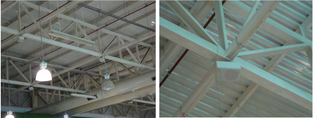
Figuras 5.50 - Vigas treliçadas. Fonte – Arquivo Pessoal, 2011.
