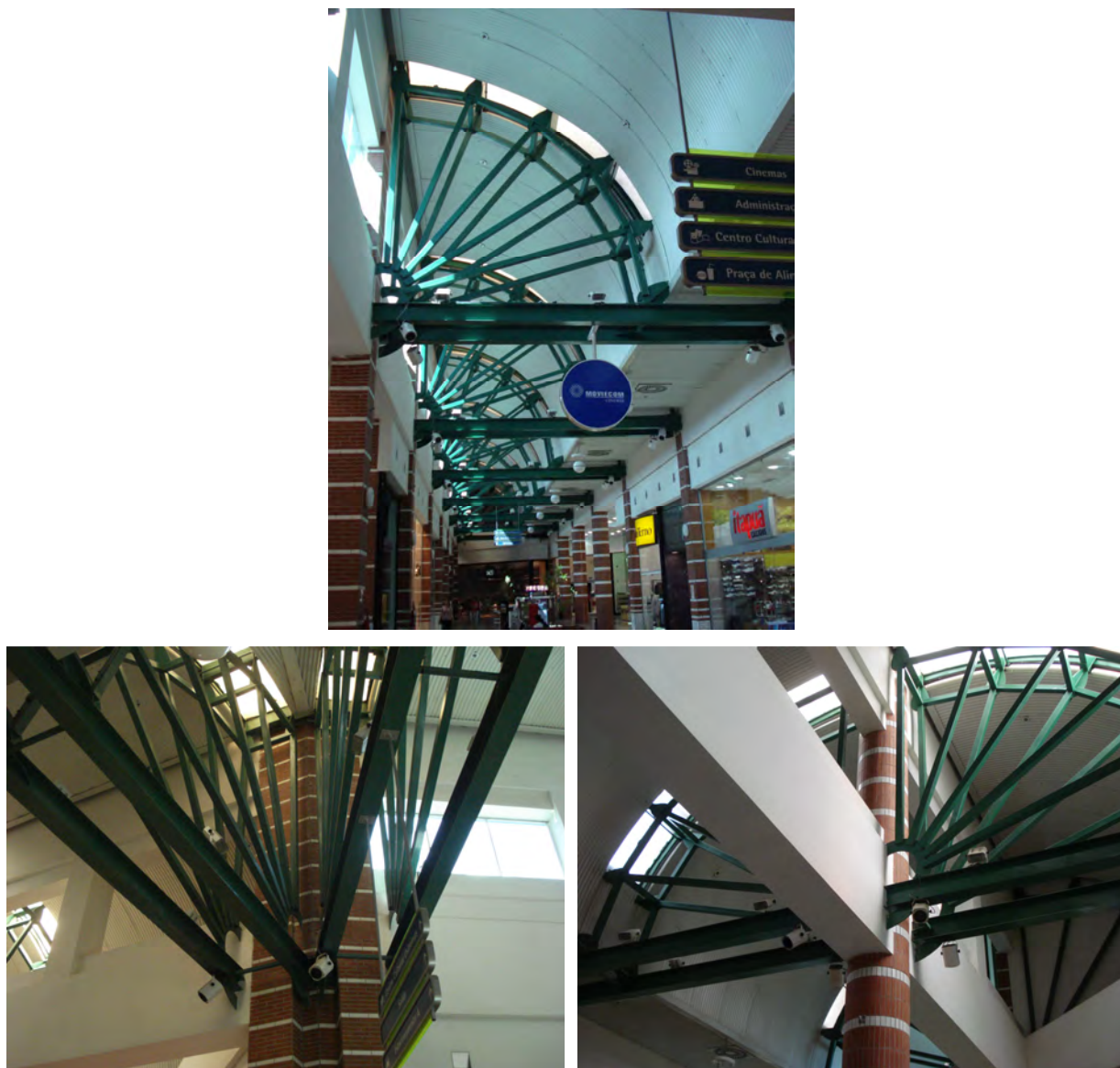
Figuras 5.32 – Vistas superior do conjunto vigas treliçadas em arco e semi-arco.
