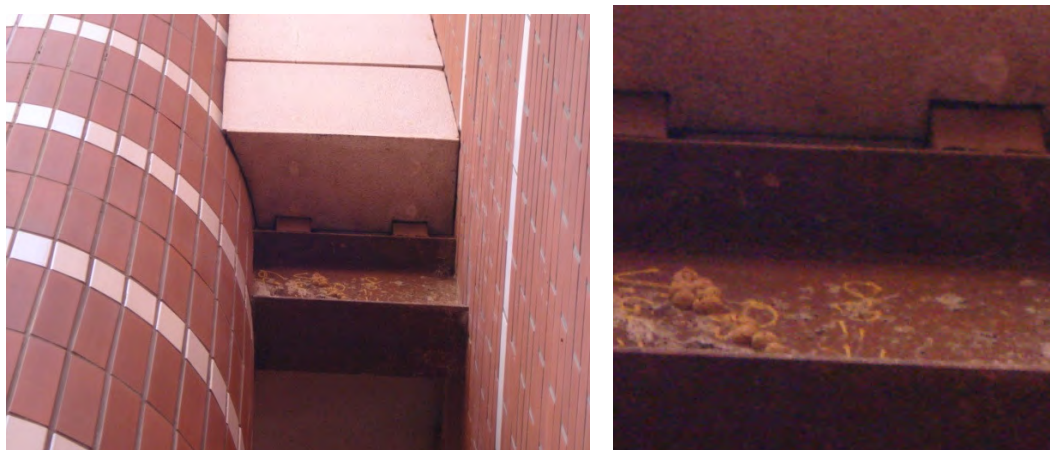
Figuras 5.34 – Conjunto estrutural Pilar e Viga / Fechamento vertical curvilíneo de fachada. Fonte: Arquivo Pessoal, 2011.
