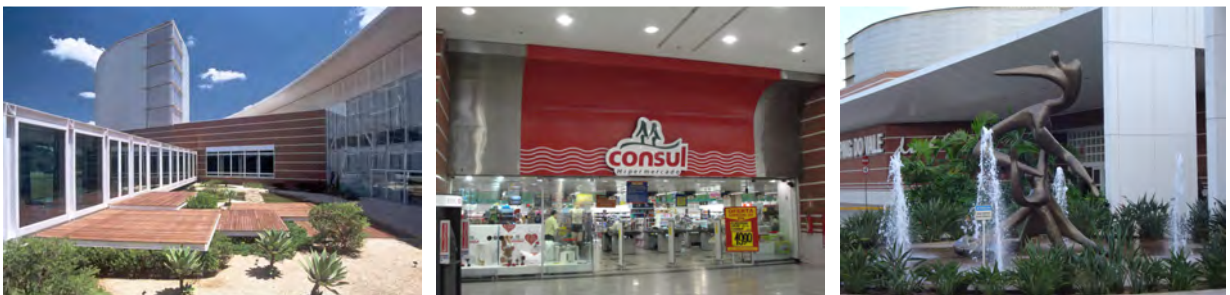
Figuras 5.23 – Vista aérea do Complexo 1998/Instalações internas e externas. Fonte: PREFEITURA MUNICIPAL DE IPATINGA, 2009.
