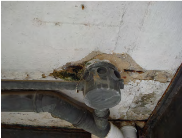
Figuras 5.3 – Infiltrações localizadas. Fonte: Arquivo Pessoal, 2011.
