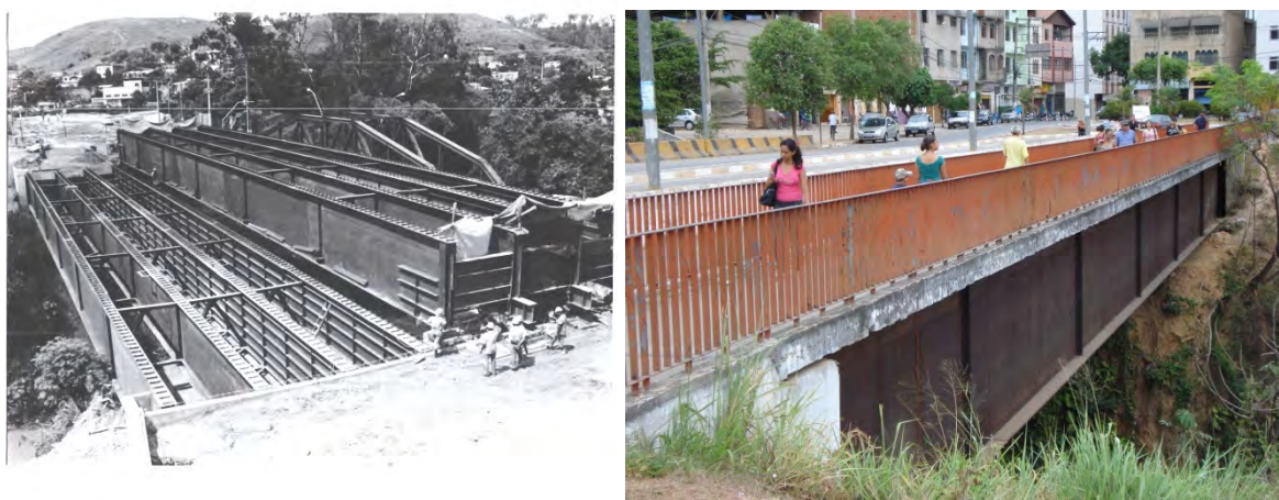
Figura I.39 - Ponte Urbana Ligação Centro/ Bairro Veneza II – Ano 1996.
