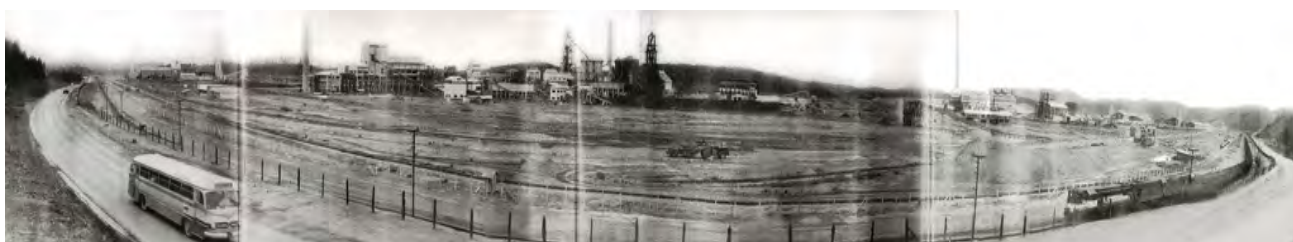
Figura 2.23 – Foto montagem panorâmica das obras dos Altos-Fornos e Coqueria da Usina, 1960.
