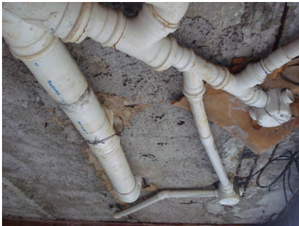
Figuras 5.3 – Infiltrações localizadas. Fonte: Arquivo Pessoal, 2011.
