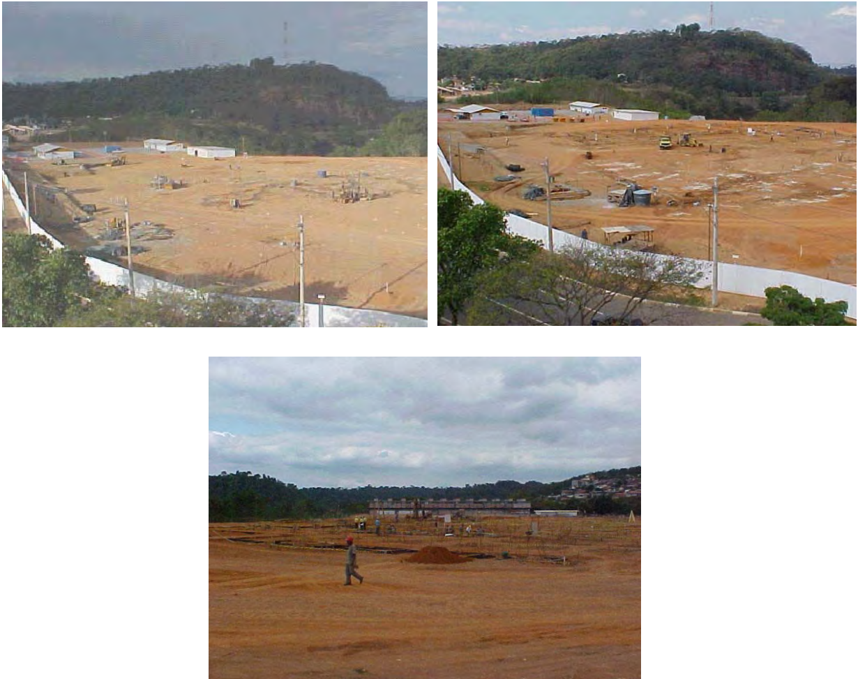
Figuras 5.11 – Canteiro de obras- Vista Panorâmica. Fonte: FUNDAÇÃO SÃO FRANCISCO XAVIER, 2009.
