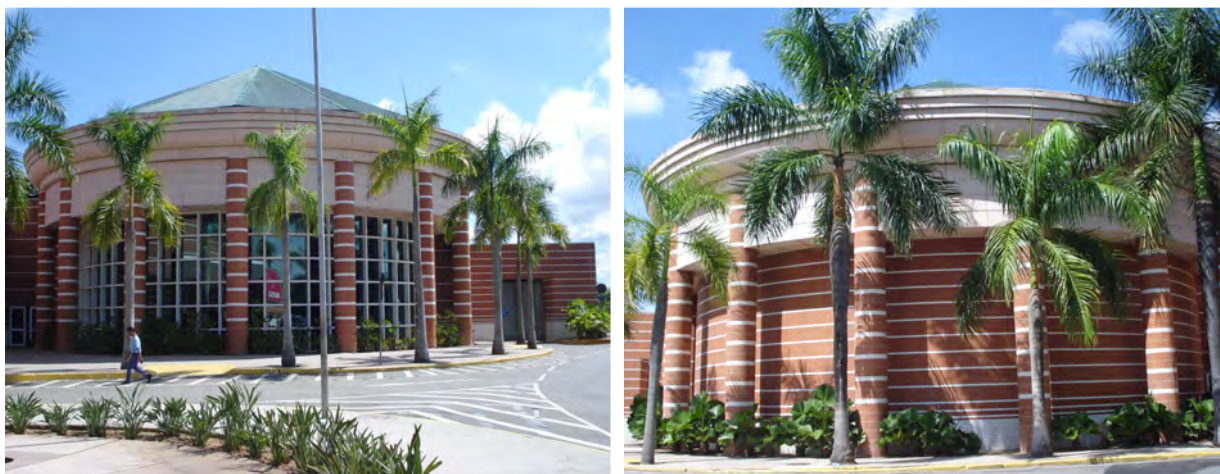
Figuras 5.30 – Vista externa da área de jogos e doca, lado sudoeste, e vista externo da área de cinemas, nordeste. Fonte: Arquivo Pessoal, 2011.
