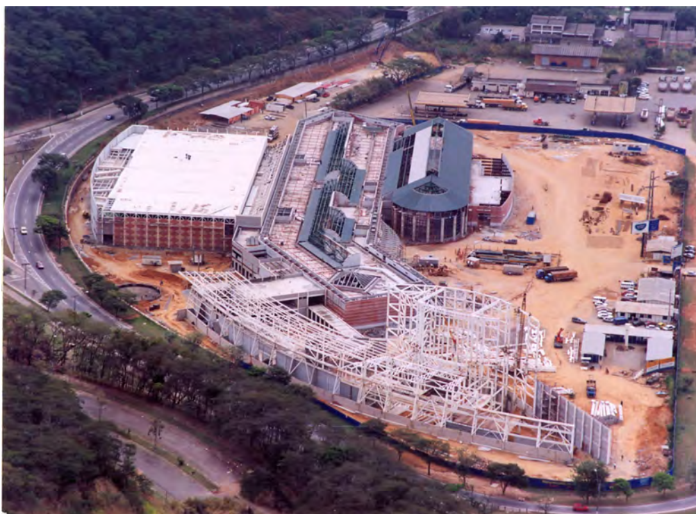
Figura 5.29 – Estruturas, fechamentos e coberturas em andamento - Shopping do Vale do Aço /Centro Cultural USIMINAS e CONSUL. Fonte: PIMENTA, 2009.
