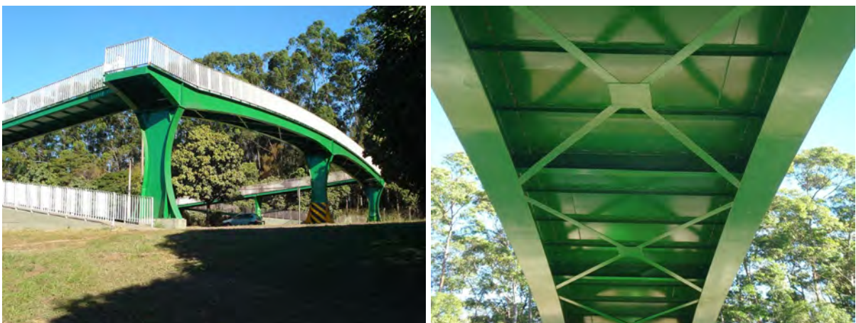
Figura I.35 - Passarela de Pedestres – Av: Cláudio Moura Bairro Novo Cruzeiro.
