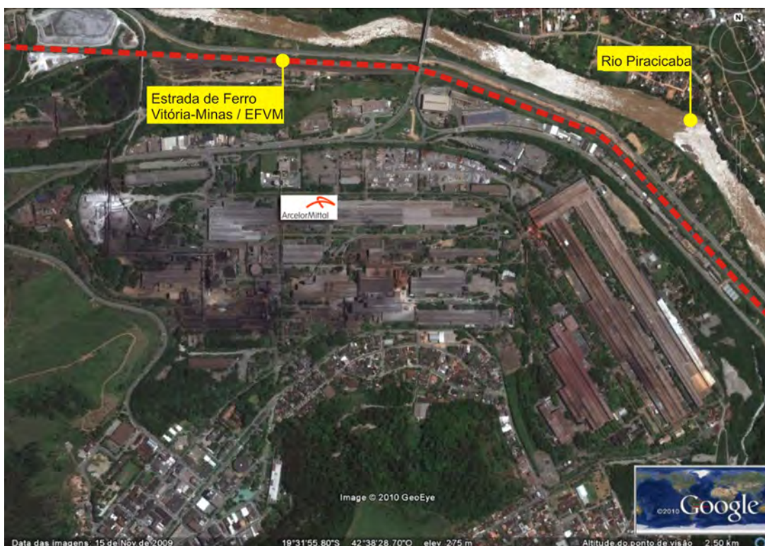
Figura 2.17 – Vista Aérea da Usina ARCELORMITTAL INOX BRASIL – Timóteo/MG. Fonte: MAPS..., 2009.
