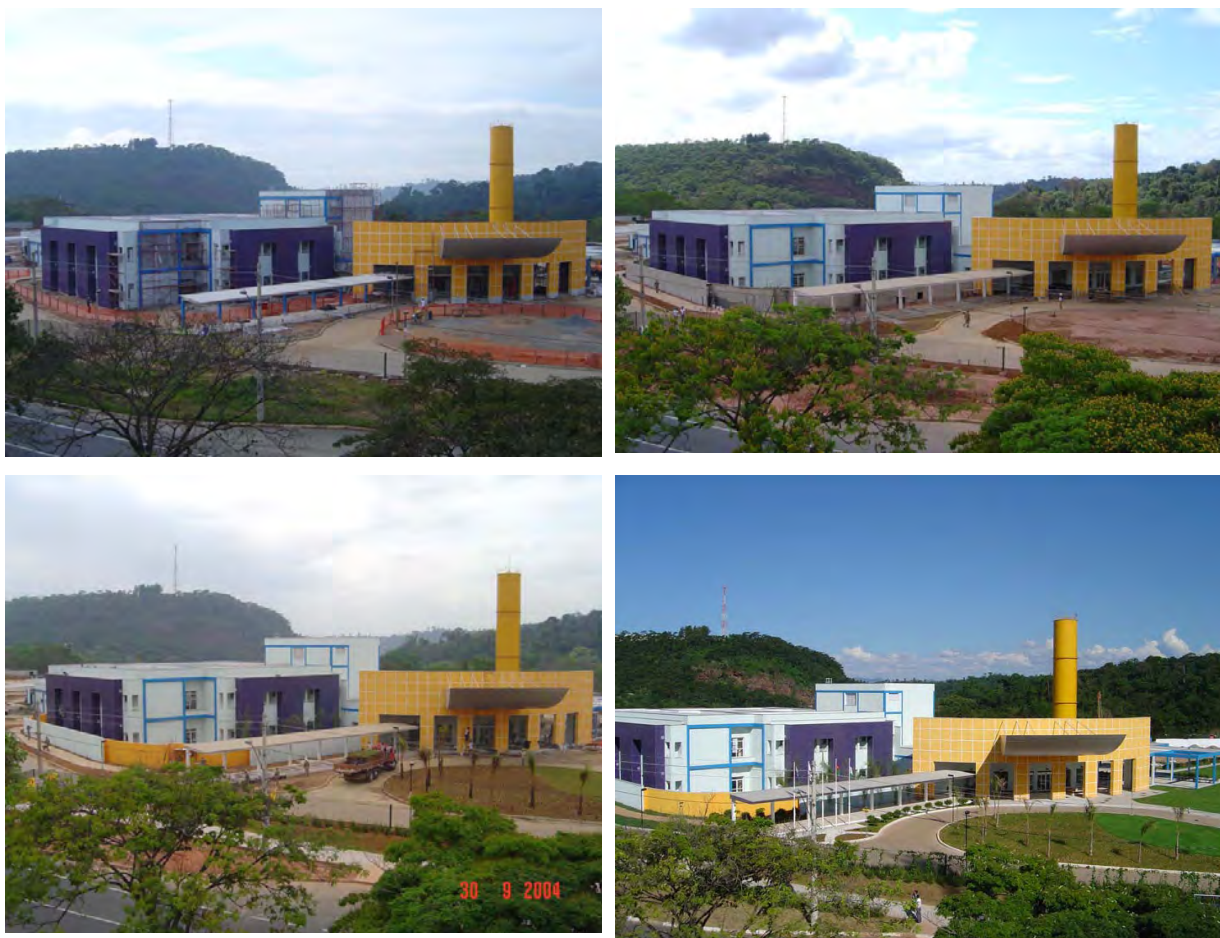
Figuras 5.15 – Acabamentos/ paisagismos/pintura/limpeza finais. Fonte: FUNDAÇÃO SÃO FRANCISCO XAVIER, 2009.
