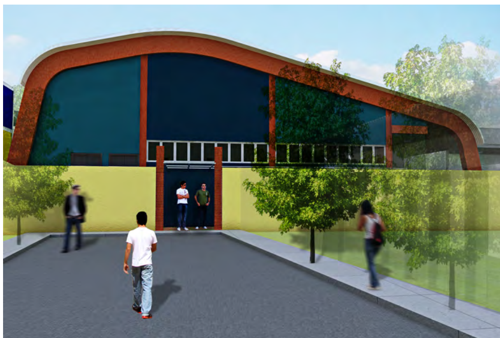
Figuras 3.28 – Complexo Ginásio / Auditório. Fonte: USIMINAS, 2011a.
