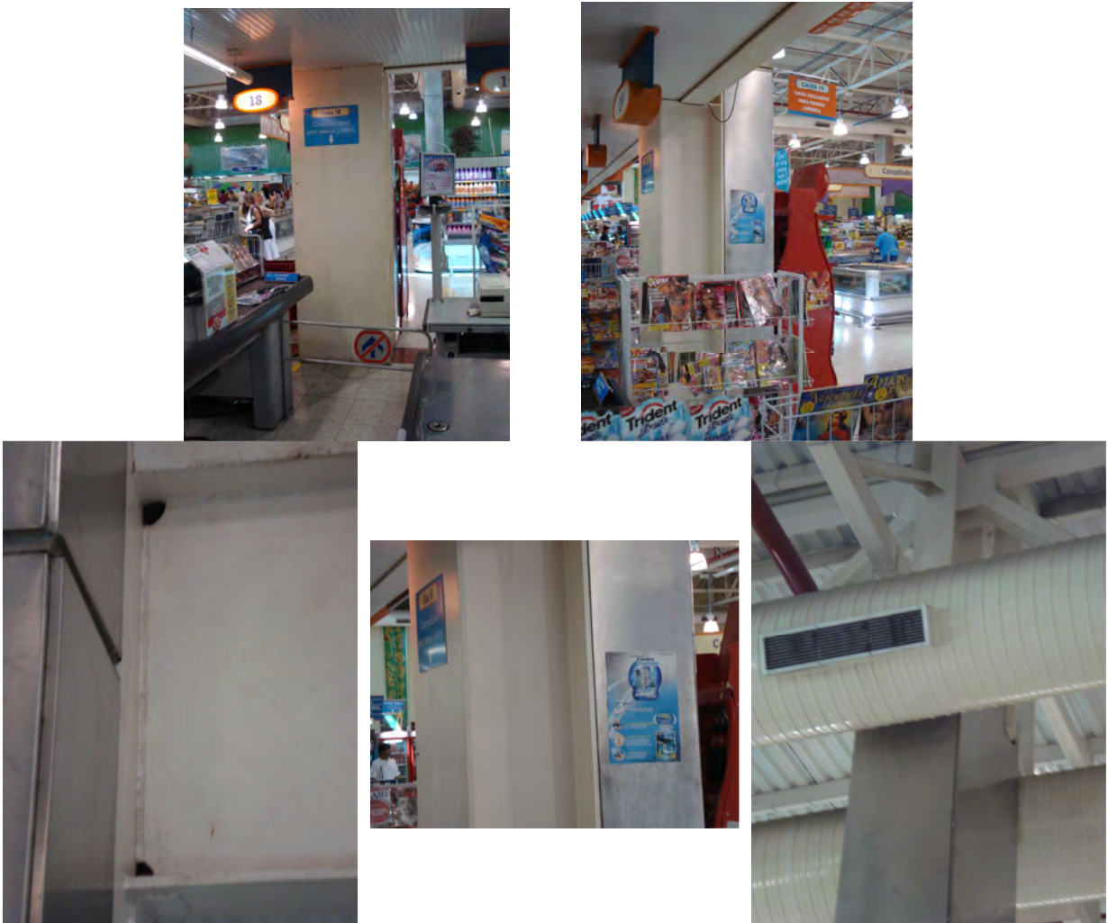
Figuras 5.54 – Revestimento de proteção dos Pilares. Fonte – Arquivo Pessoal, 2011.
