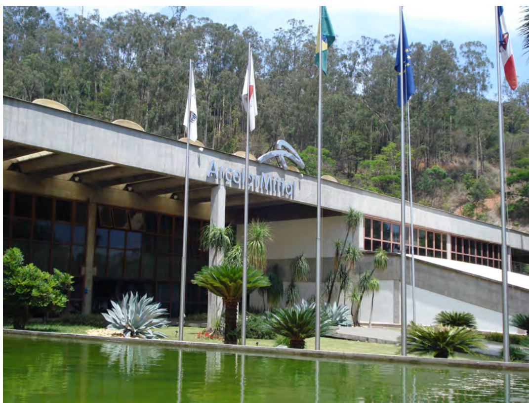
Figura 2.18 – Escritório Central ARCELORMITTAL INOX BRASIL, 2010 – Timóteo/MG. Fonte: Arquivo Pessoal, 2011.
