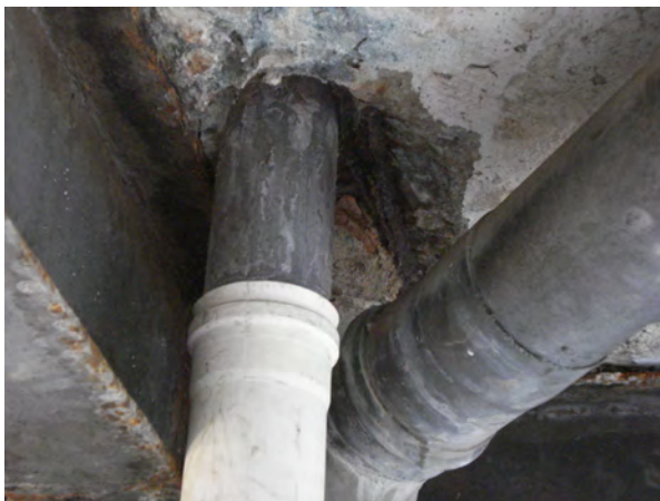
Figuras 5.3 – Infiltrações localizadas. Fonte: Arquivo Pessoal, 2011.
