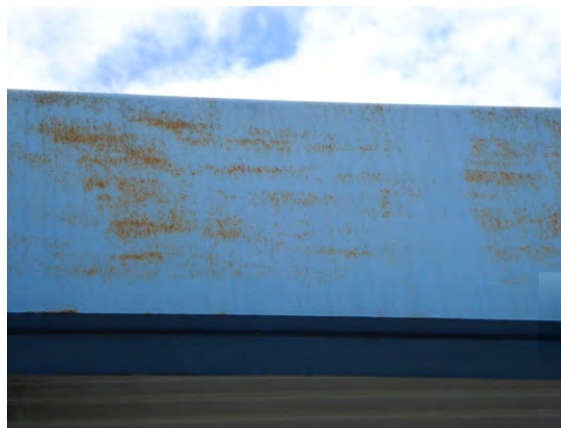
Figura 5.19 – Visto a baixa qualidade do tratamento anticorrosivo (limpeza, fundo e acabamento) inicia-se o processo de corrosão superficial e de conexão calhas/pilares. Fonte: Arquivo Pessoal, 2011.
