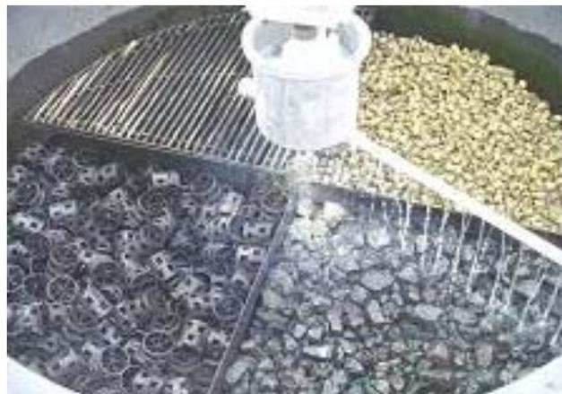
**Figura 3.2** - Filtro biológico percolador, dividido em quatro compartimentos, preenchidos com diferentes meios suportes para crescimento microbiano. Um braço giratório despeja o efluente do reator *UASB* a ser tratado. Fonte: Tavares, 2008.
