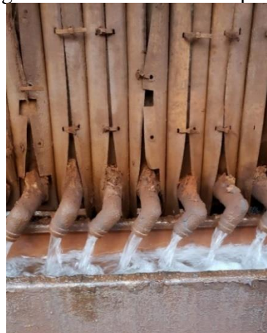
Figura 26 - Filtrado do filtro prensa
