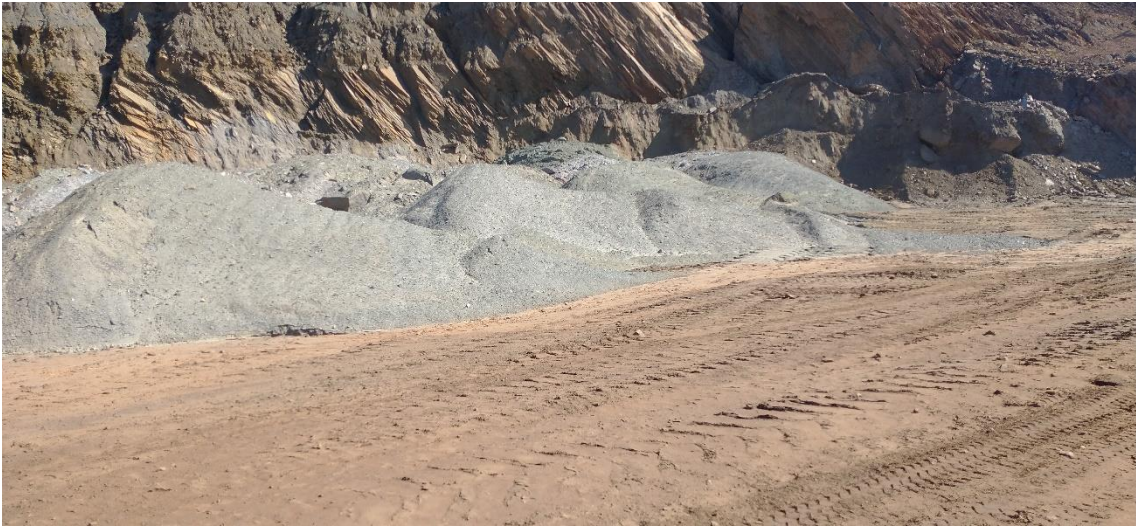
Figura 57: Material a cabamento de acessos.
