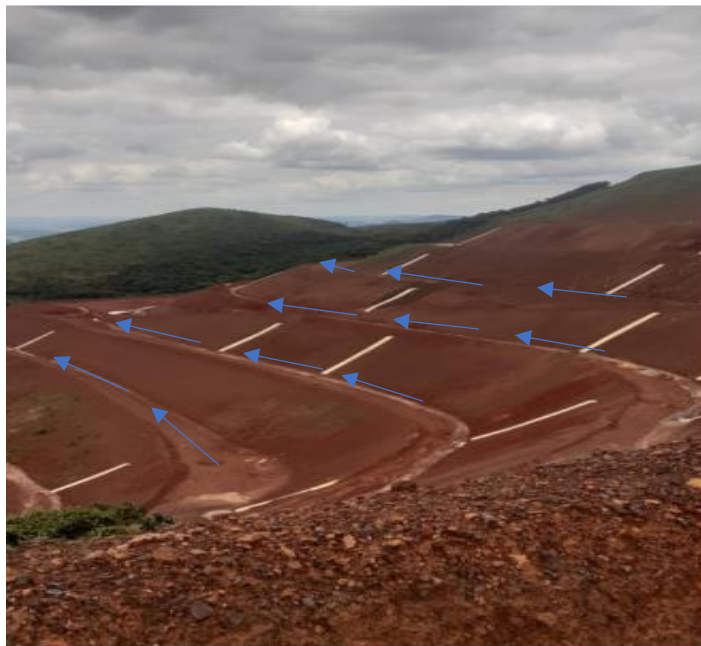
Figura 35 - Drenagem de bancos
