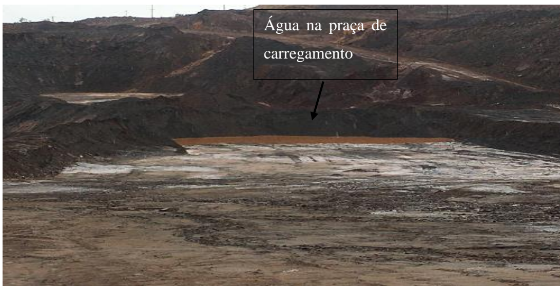
Figura 33 – Ausência de drenagem na praça de carregamento
