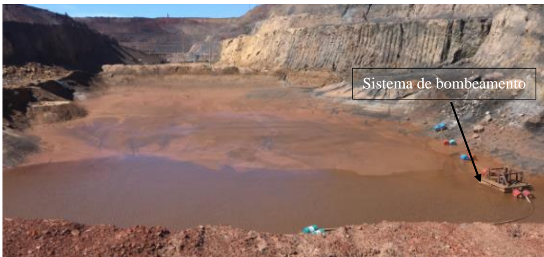
Figura 36 - Sump para drenagem da água
