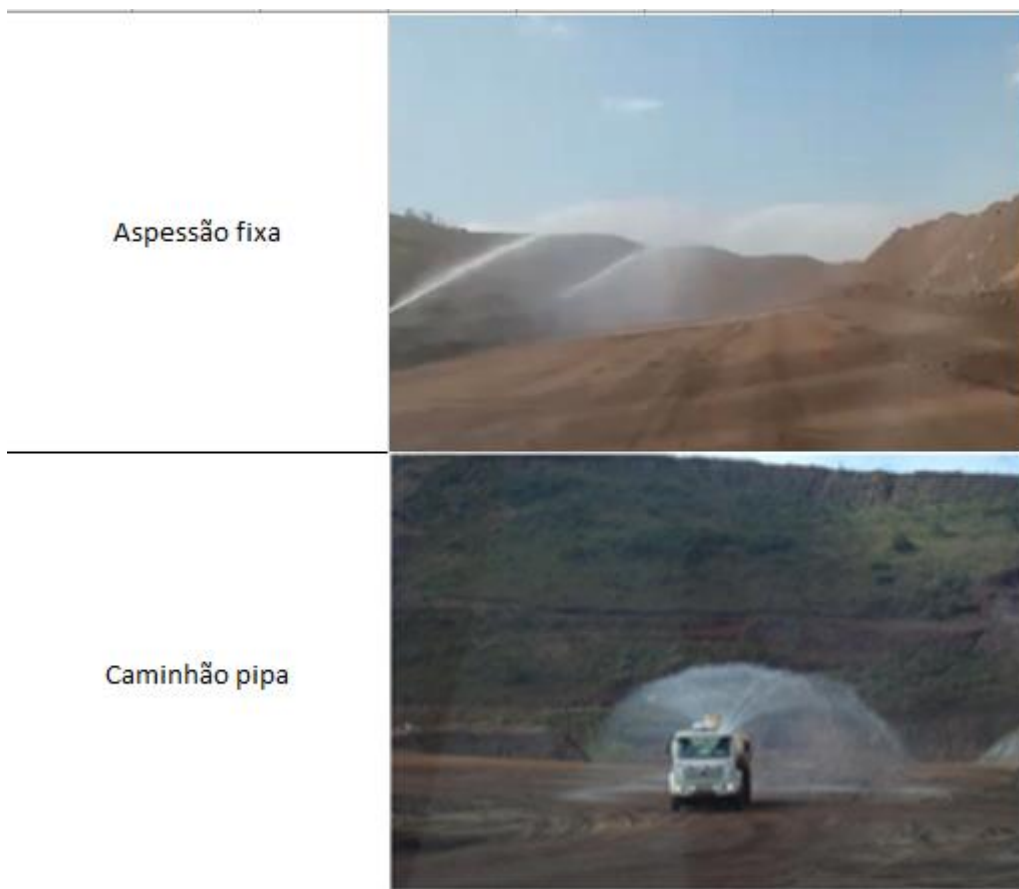
Figura 38 - Umidificação de estradas e taludes
