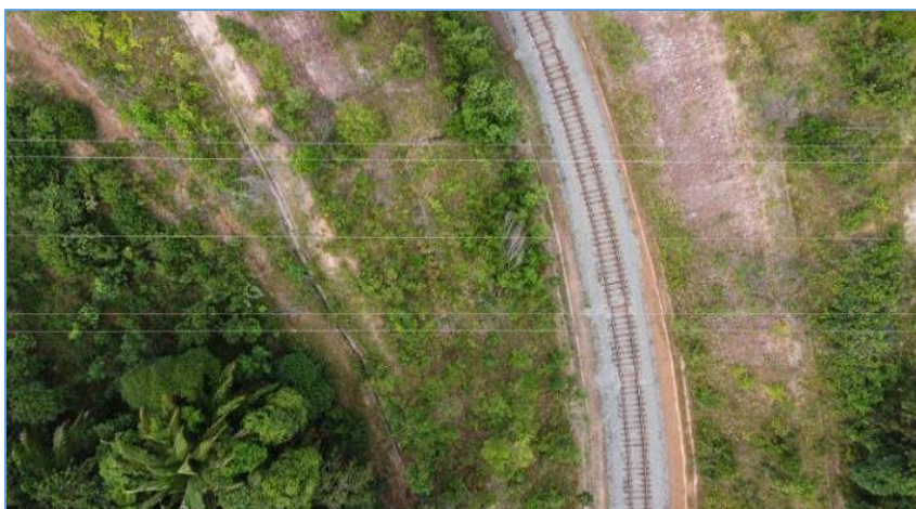
Figura 6.40: Vista superior de trecho da LT.
