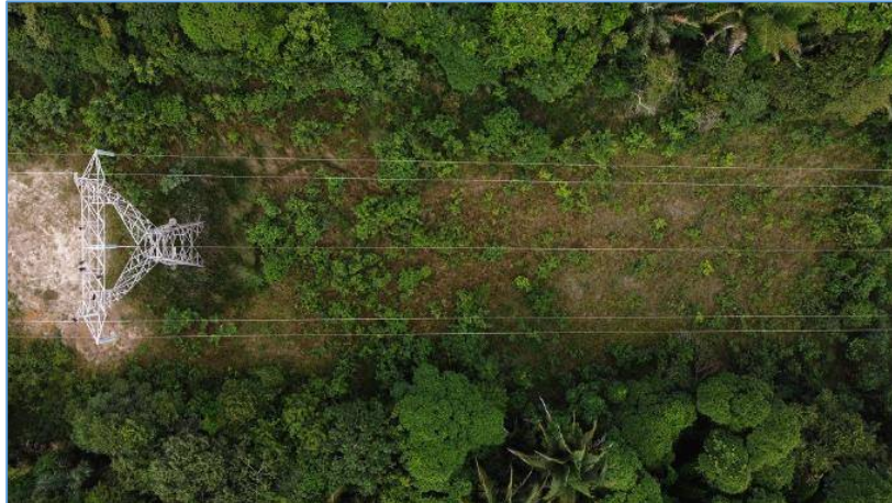
Figura 5.6: Vista superior da LT com VANT a 50 metros de altura.
