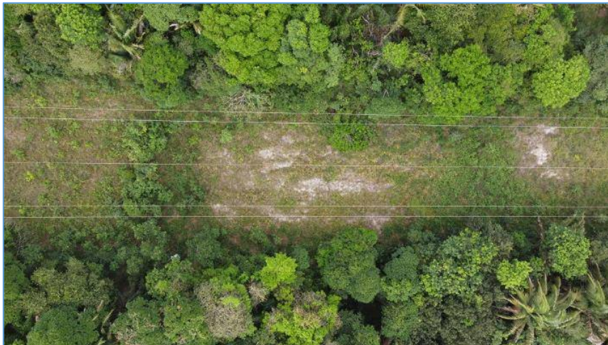
Figura 6.9: Vista superior de trecho da LT.
