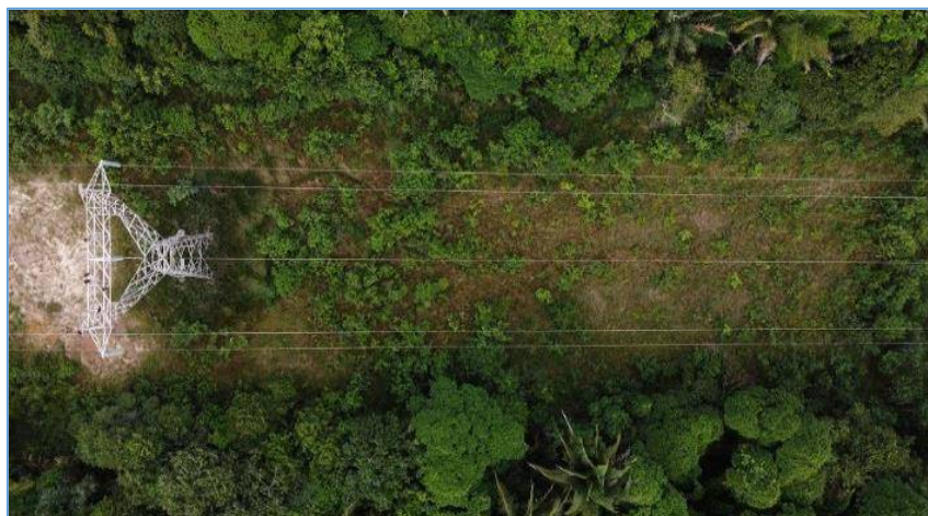
Figura 6.5: Vista superior de trecho da LT.
