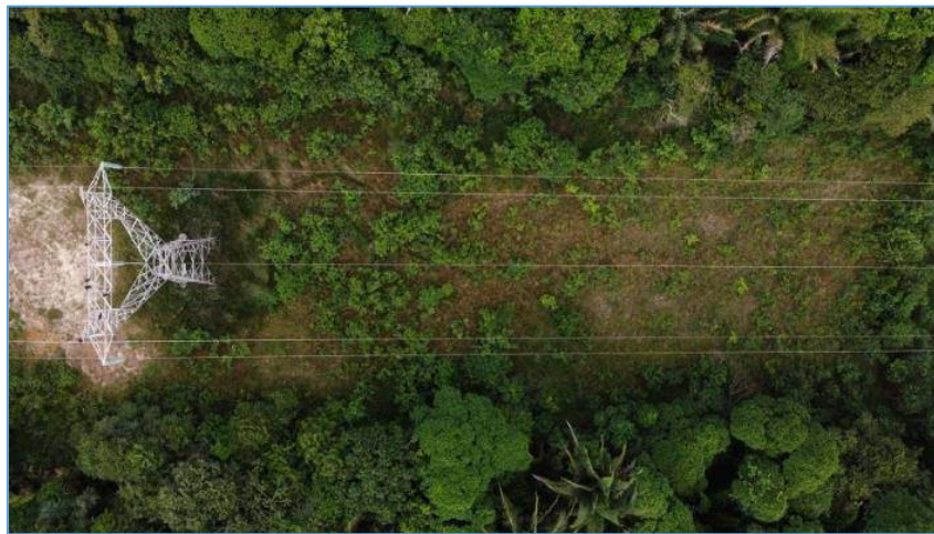
Figura 6.15: Vista superior de trecho da LT.
