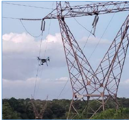
Figura 1.3: Inspeção em torre de LT com uso de um VANT.
