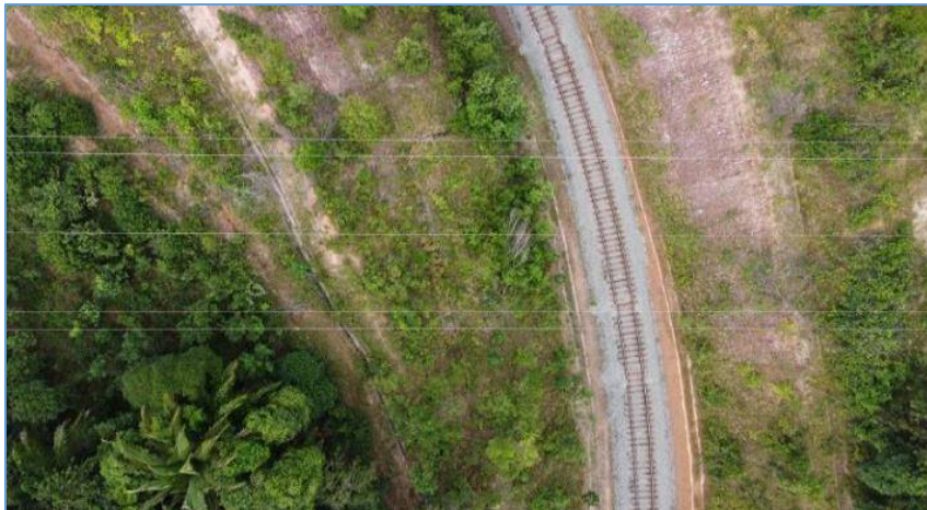
Figura 6.3: Vista superior de trecho da LT.
