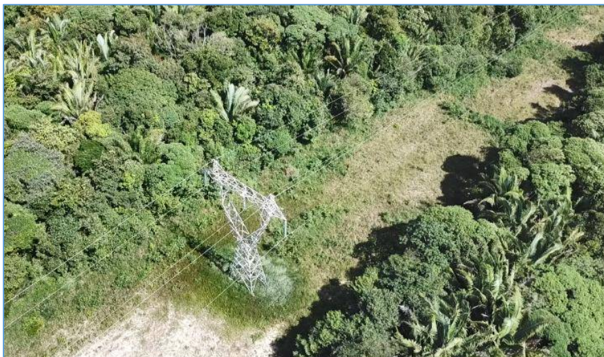
Figura 1.1: Inspeção em torre e LT com uso de um VANT.
