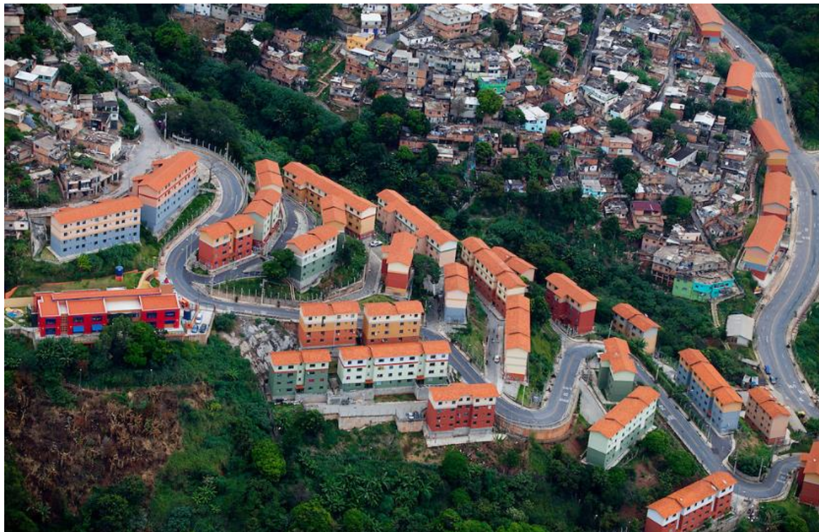
Imagem 10: Obras realizadas pelo PVV
