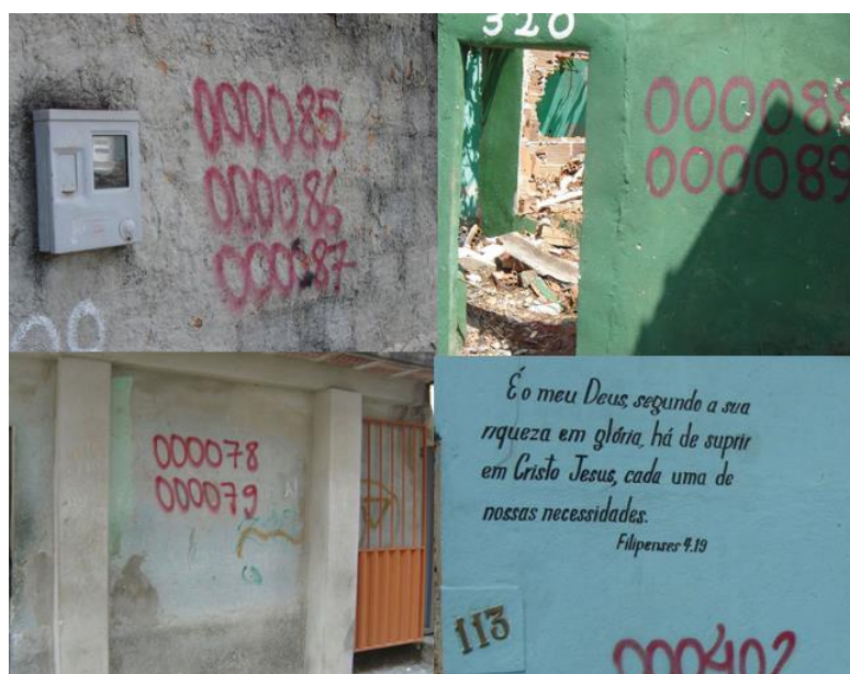
Imagem 06: Muros das casas com os números que indicavam que o imóvel seria demolido
