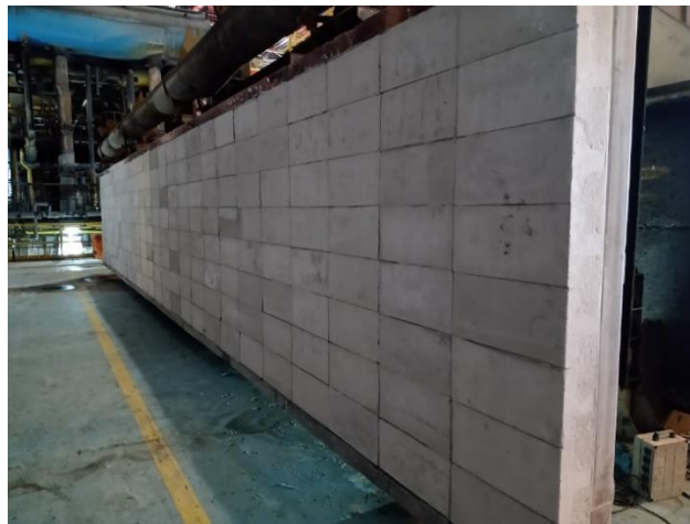
Figura 5.29. Montagem da porta seca concluída.
