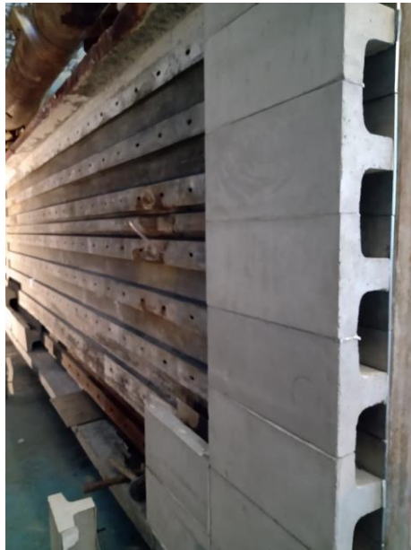
Figura 5.25. Montagem da porta seca.
