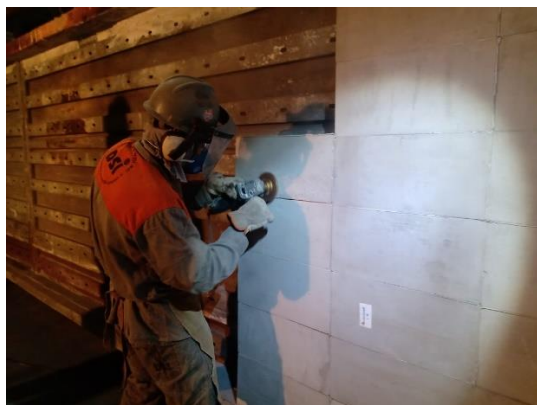
Figura 5.27. Lixamento na face do bloco.
