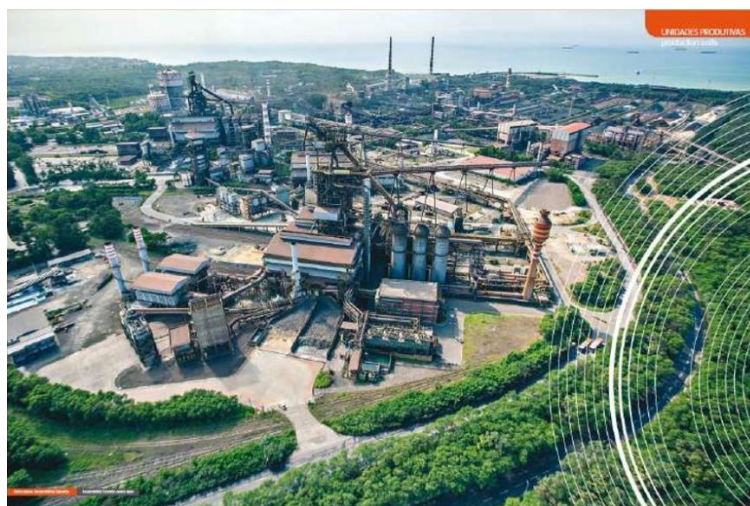
Figura 3.3 Vista aérea da ArcelorMittal Tubarão (Fonte: Catálogo de produtos laminados – Edição 2015 – ArcelorMittal Aços Planos América Latina – Brasil).
