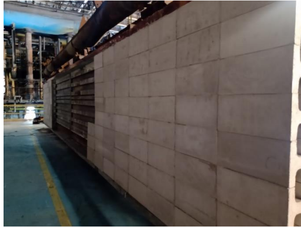
Figura 5.28. Continuidade da montagem da porta.
