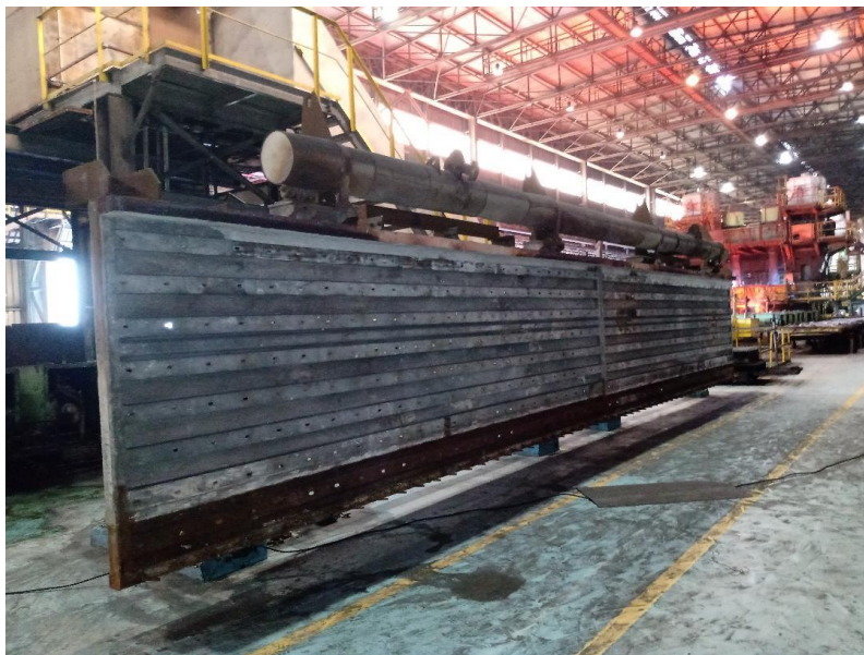
Figura 5.20. Parte estrutural da porta seca.
