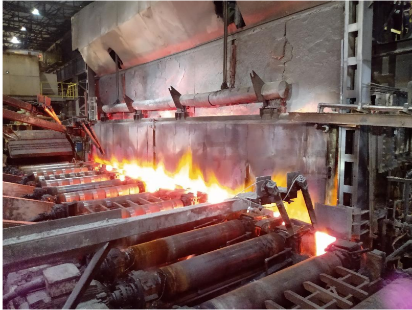
Figura 3.7. Passagem de chama da zona de encharque na porta de desenformamento.
