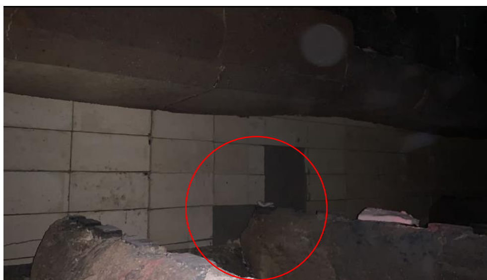
Figura 5.32. Recuperação da região danificada da porta.
