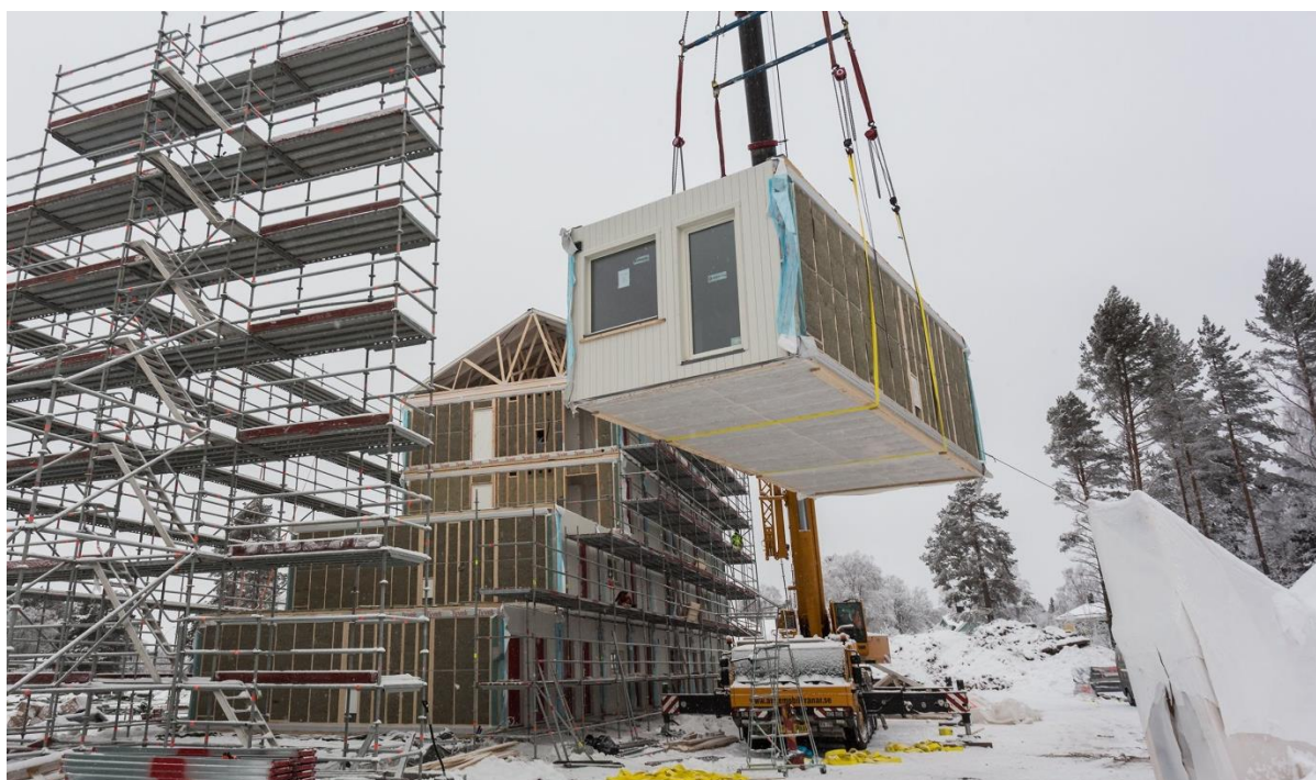
Figura 09 – Módulo tridimensional acabado sendo instalado durante rigoroso inverno
