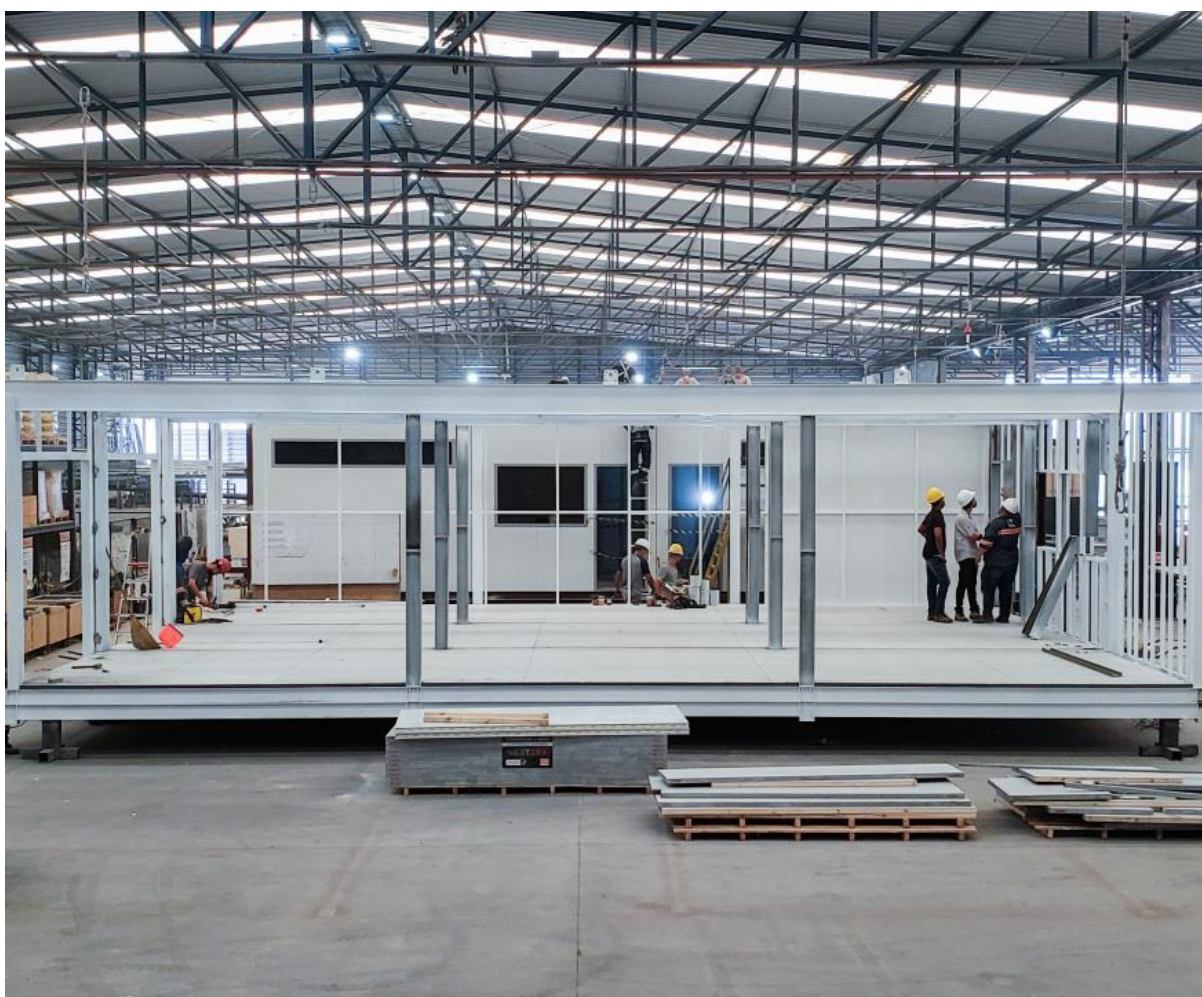
Figura 31: Montagem de módulos na fábrica da Empresa I
