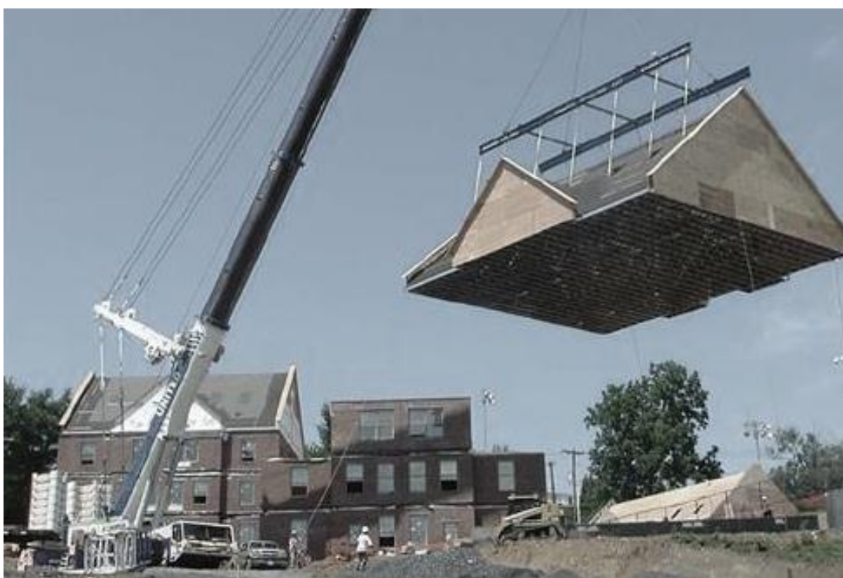
Figura 11 – Módulos intersticiais sendo içados e alocados no canteiro
