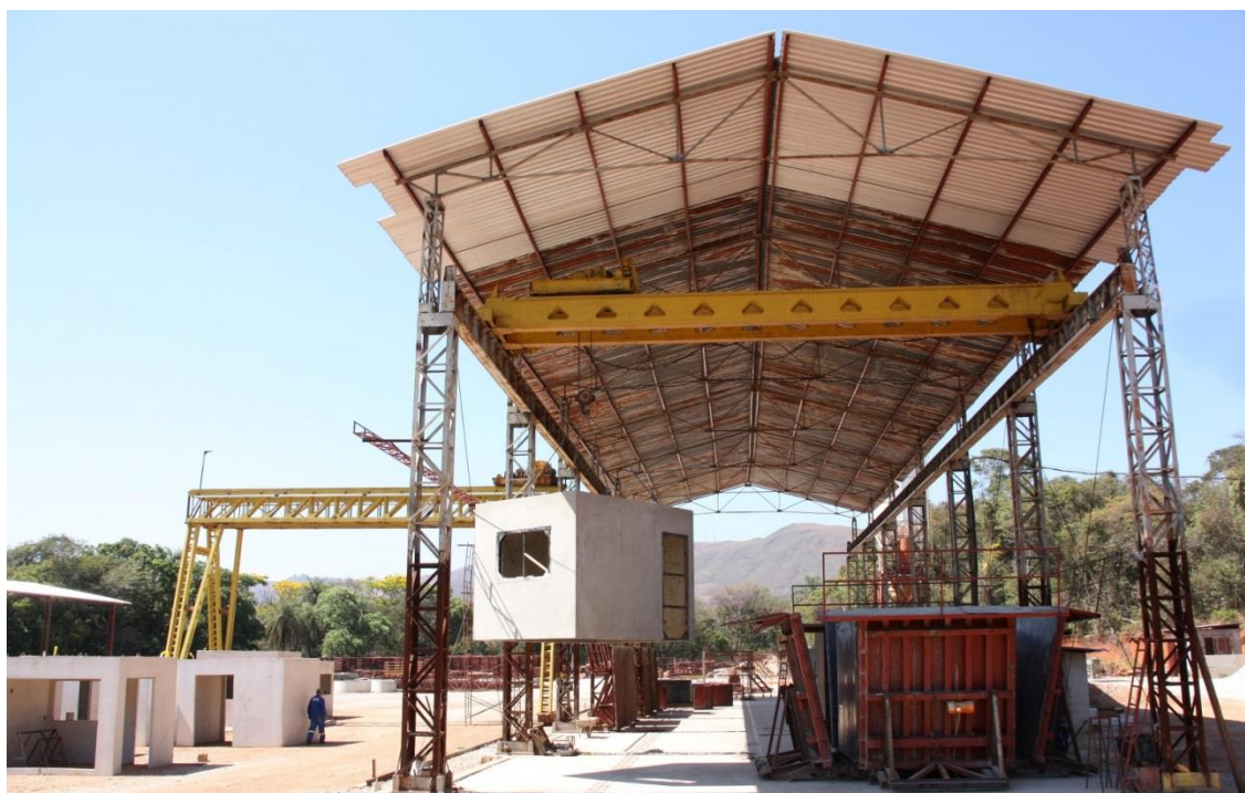
Figura 29: Produção de módulos de concreto
