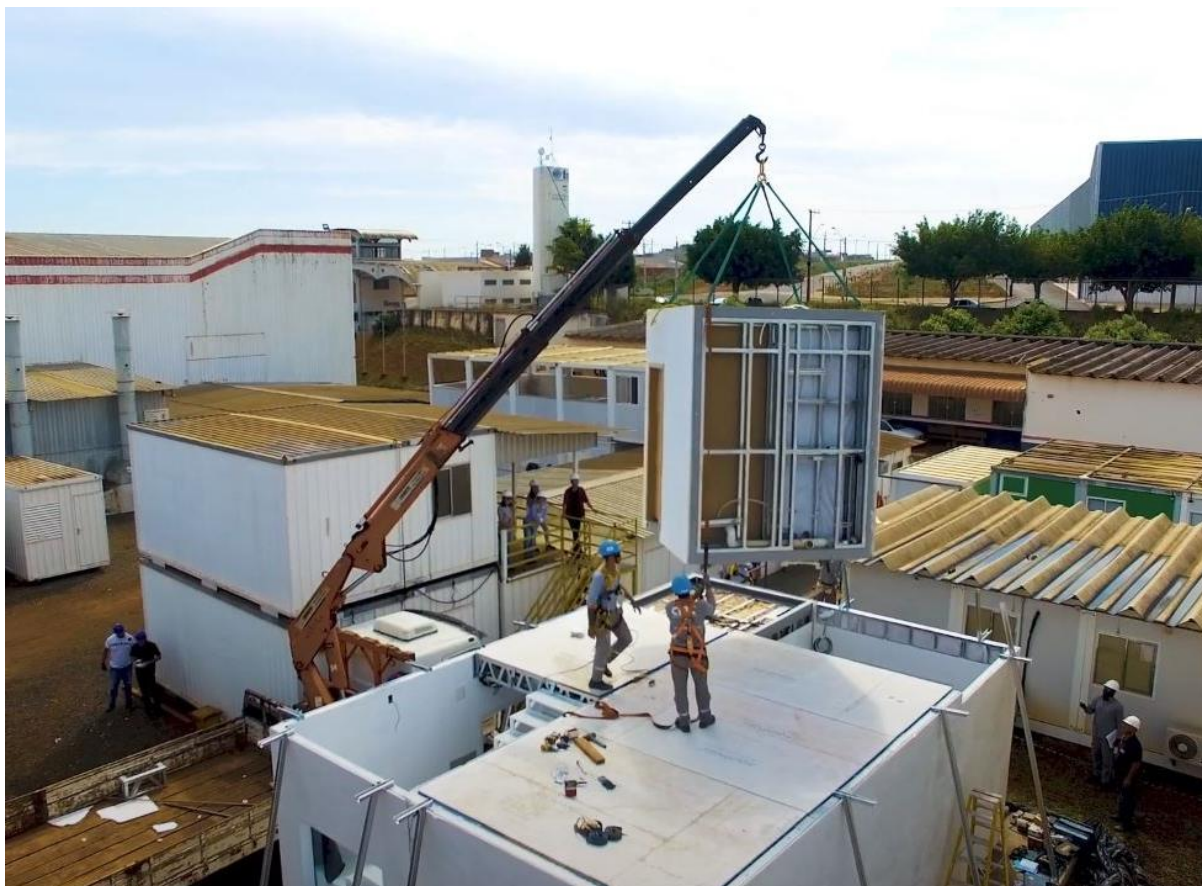
Figura 44: Construção do protótipo da Empresa II em caráter híbrido, utilizando o sistema M3D para a composição das áreas molhadas e restante em sistema 2D.
