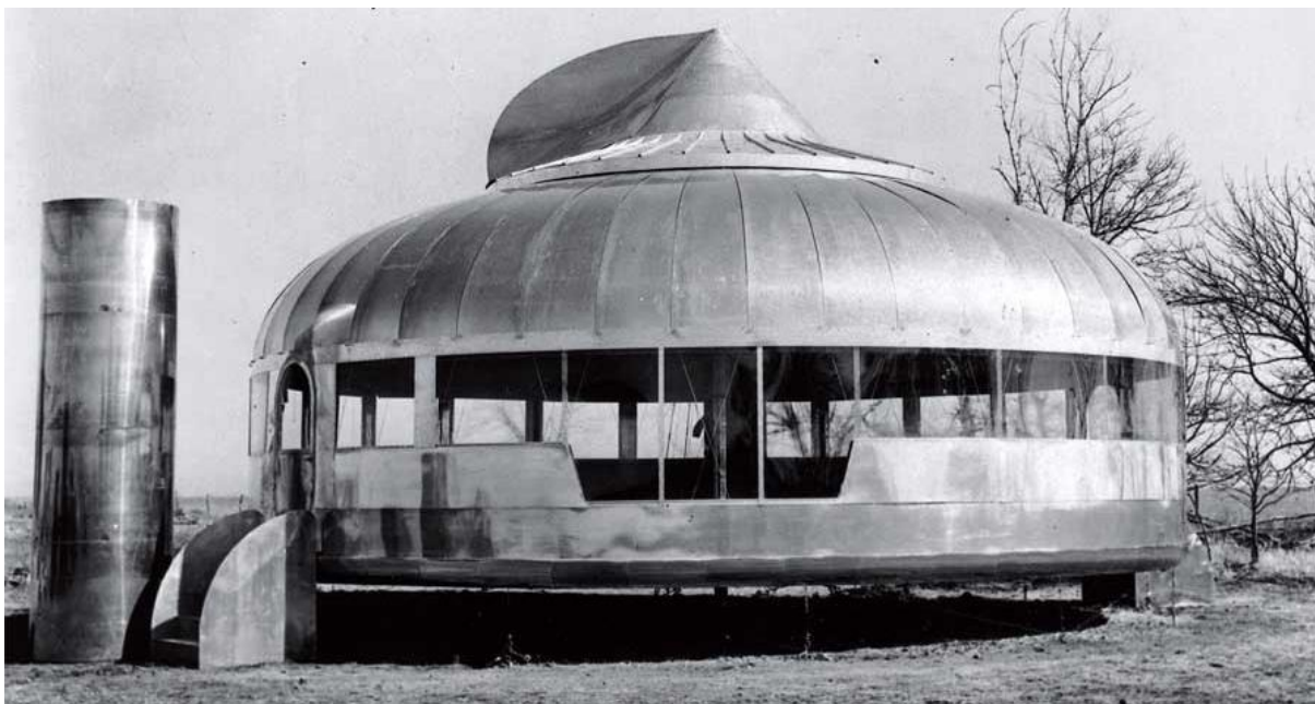
Figura 17: Protótipo Dymaxion / Wichita que usa estrutura e revestimento de alumínio
