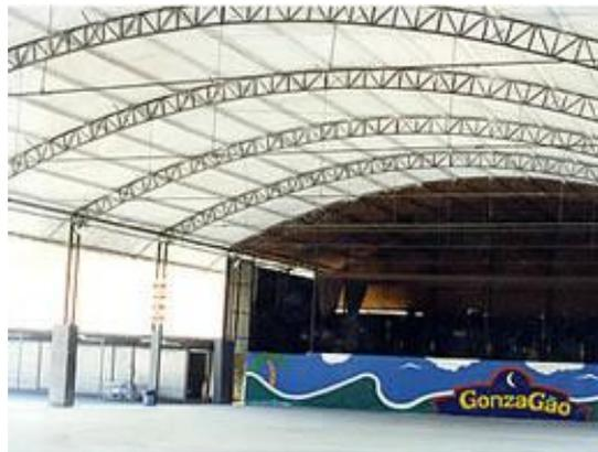
Figura 2: Arco atirantado em telhados<sup>2</sup>
