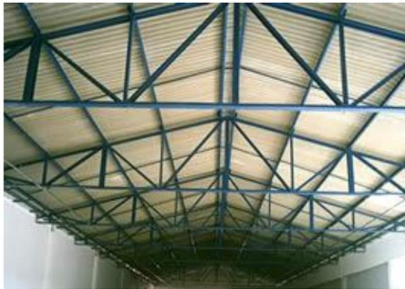
Figura 1: Tesoura em telhados<sup>1</sup>
