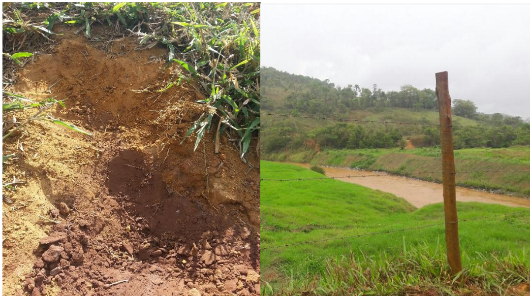
Figura 2.8- a: Topsoil depositado sobre a lama. B: Brachiarias que foram semeadas para pastagem sobre o topsoil (esquerda) e contenção da erosão (direita). Fonte: A autora.
