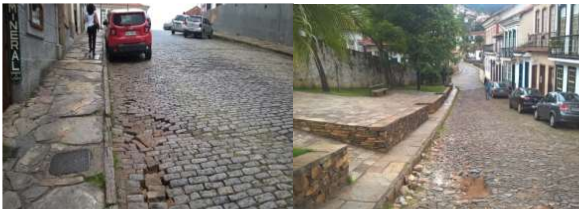
Figura 6: Fotografia de parte do Roteiro 2, demonstrando aclive e piso irregular (esquerda); e fotografia de parte do Roteiro 1, no Bairro Antônio Dias, demonstrando declive e piso irregular (direita). Foto: Dados dos autores (2017).
