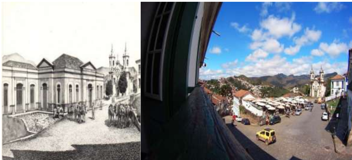
Figura 2: Largo de Coimbra, logradouro de Ouro Preto/MG em 1940 (esquerda); e em 2016 (direita) e suas funcionalidades: mercado e pousio de carroças, e feira de pedra-sabão respectivamente. Fonte: Arquivo Público Municipal de Ouro Preto 13 (esquerda) e dados dos autores (direita).
