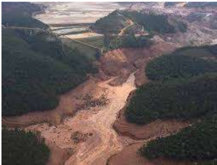
Figura 3.7 - Barragem de Fundão, em Mariana (MG), após o processo de liquefação.
