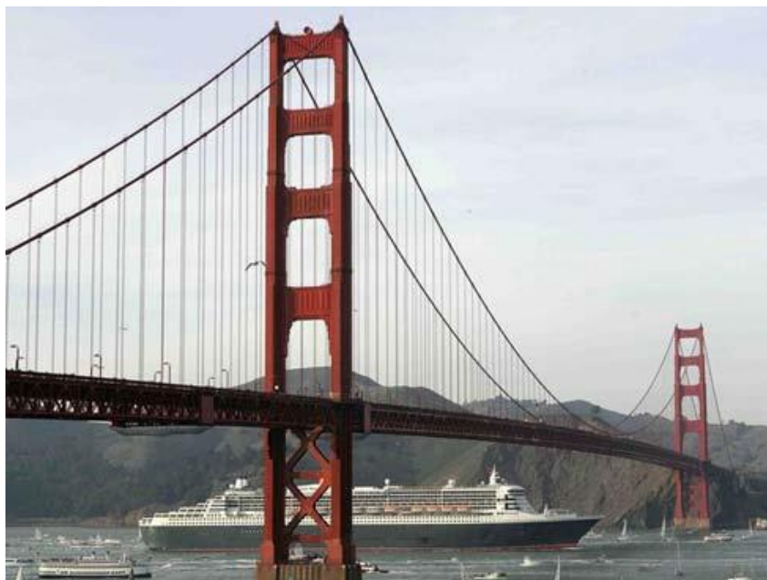
Figura 2.8 – Ponte Golden Gate (San Francisco - EUA)
