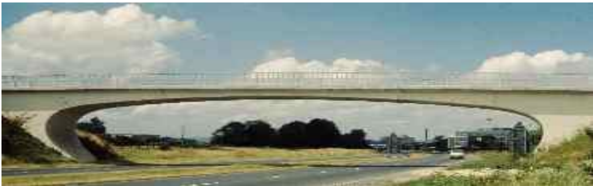
Figura 3 - Viaduto apórticado – Inglaterra
