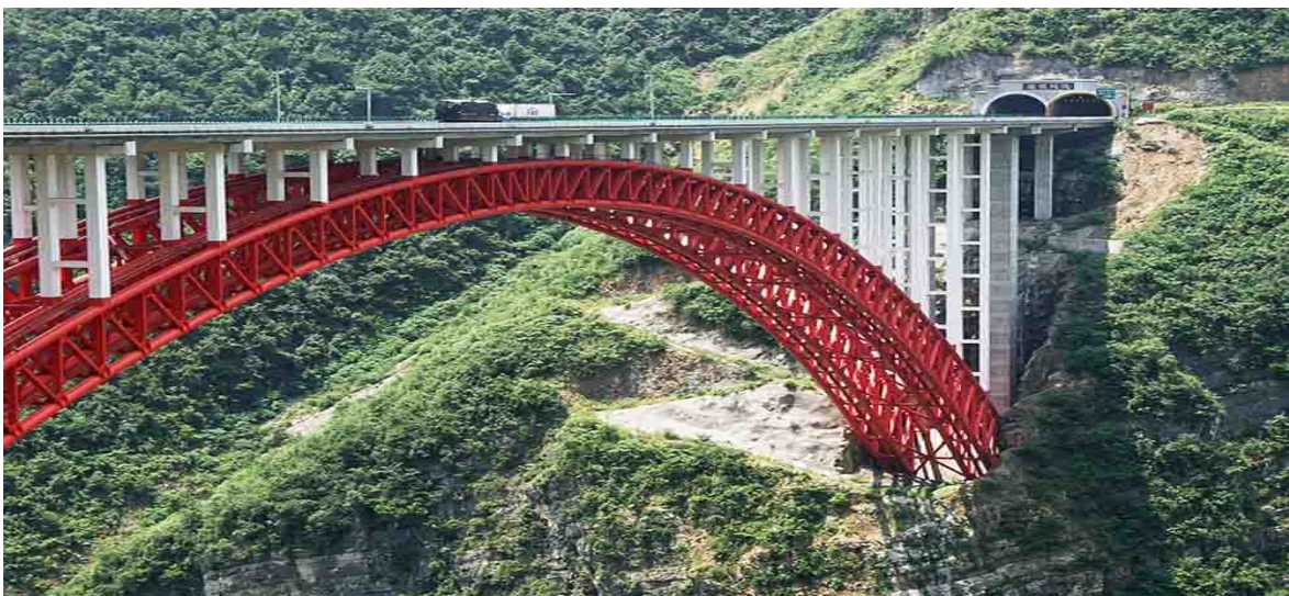
Figura 2 - Ponte Rodoviária do Rio Zhijinghe - China
