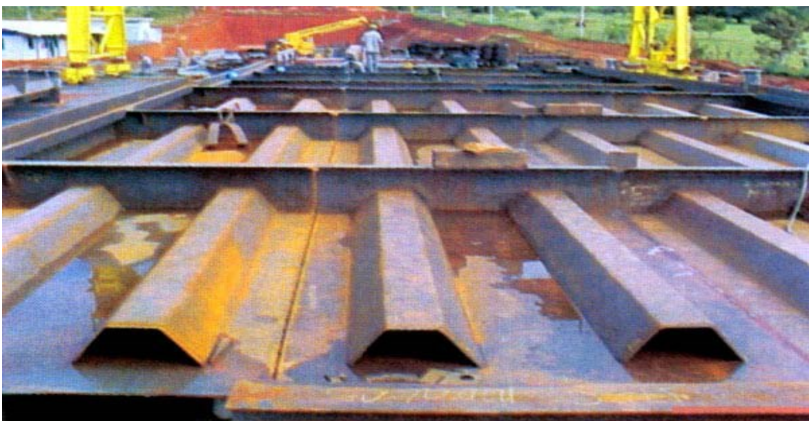
Figura 10 - Montagem de tabuleiro ortotrópico – Ponte JK –Brasília
