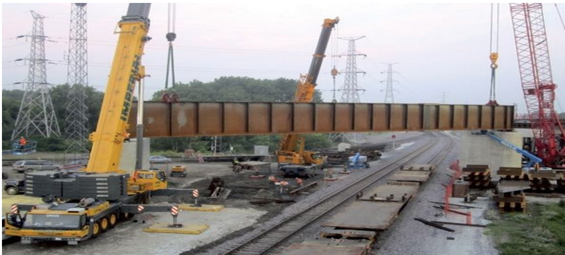
Figura 29 - Içamento de viga - Estados Unidos
