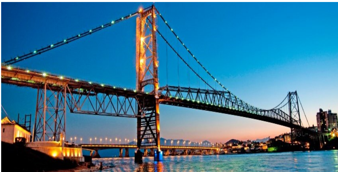
Figura 5 - Ponte Pênsil Hercílio Luz – Florianópolis - SC
