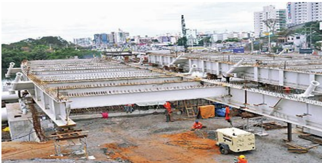
Figura 12 - Tabuleiro da Ponte da Passagem – Vitória ES, fase de montagem
