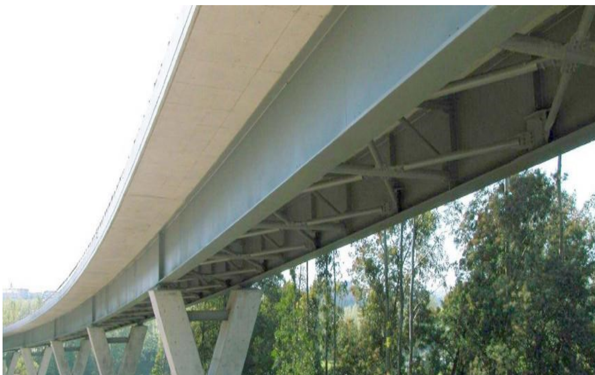
Figura 8 - Viaduto Parque da Maia – Portugal
